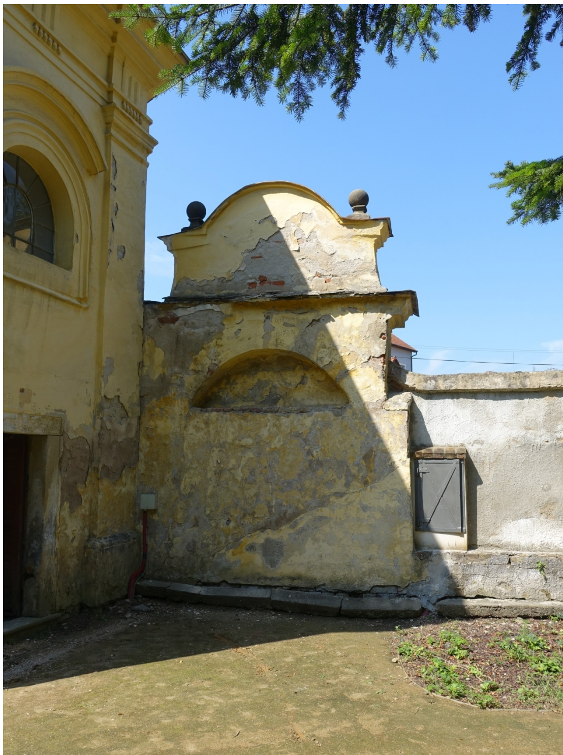
Přechod mezi kaplí a ohradní zdí, pohled od V – na vrcholové římse dvě kuželky završené koulí, stav před restaurováním
