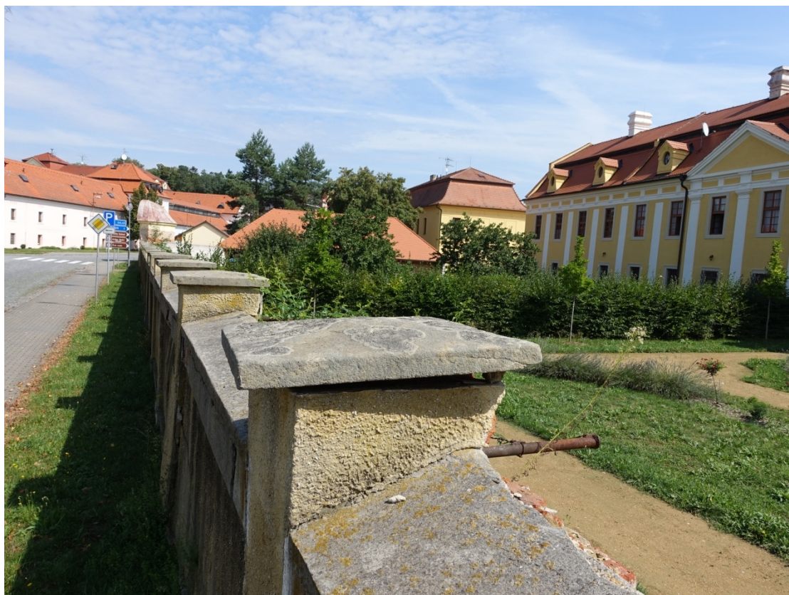
Ohradní zeď, pohled od J – kamenné stříšky pilířů jsou napadeny biodepozity (mechy, lišejníky) a černými usazeninami, stav před restaurováním
