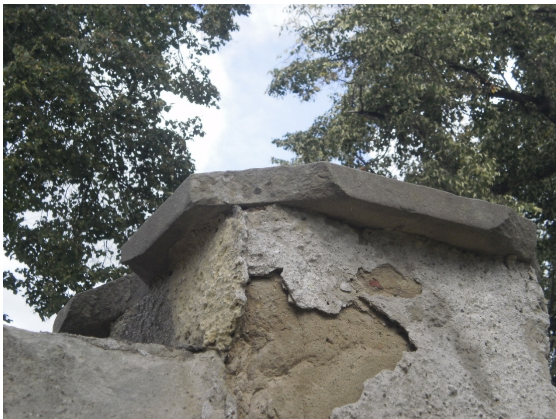
Ohradní zed', detail kamenné stříšky pilíře – patrná mechanická poškození, stav před restaurováním
