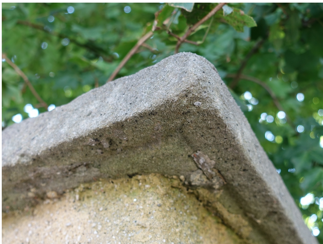
Ohradní zeď, detail struktury kamene stříšek pilířů – stav před restaurováním
