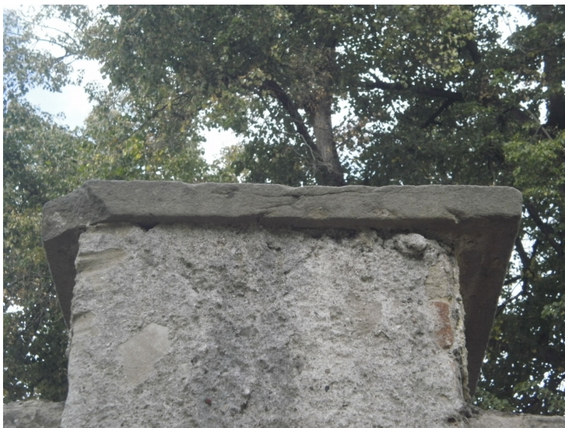
Ohradní zeď, detail kamenné stříšky pilíře – patrná mechanická poškození a praskliny, stav před restaurováním
