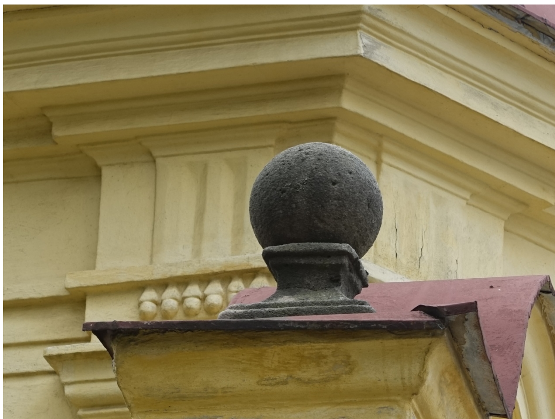
Ohradní zeď, detail kamenné kuželky zakončené koulí – patrná mechanická poškození i prasklina ve výžlabu, stav před restaurováním
